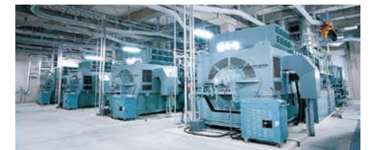
液晶工場では、コ・ジェネレーションシステムの導入により、クリーンなLNG(液化天然ガス)による自家発電を行っています。(CO 2 削減効果76,000t-CO 2 /年)
