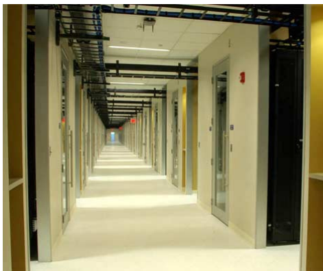
(d) The Aisle of data Halls
