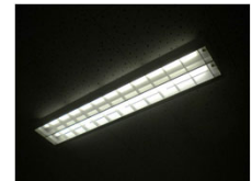
ルーバーを取り付けた蛍光灯
