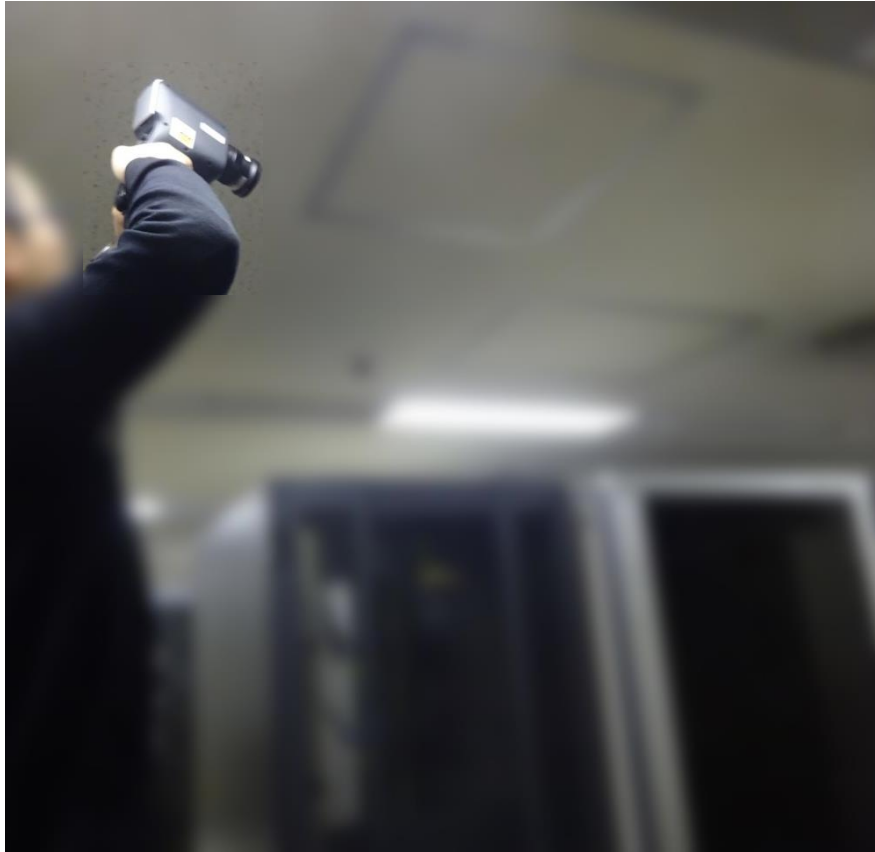
サーモカメラにてサーバールーム温度計測中
