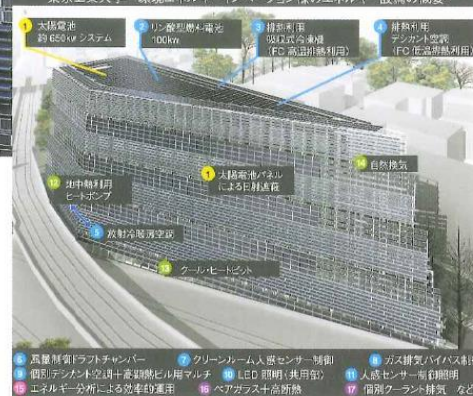
東京工業大学 環境エネルギーイノベーション棟のエネルギー設備の概要
