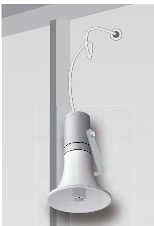
ホーンスピーカーは、ボルトの緩みや、腐食によるアングル破断で落下につながる恐れがあります。定期的な点検が必要です
