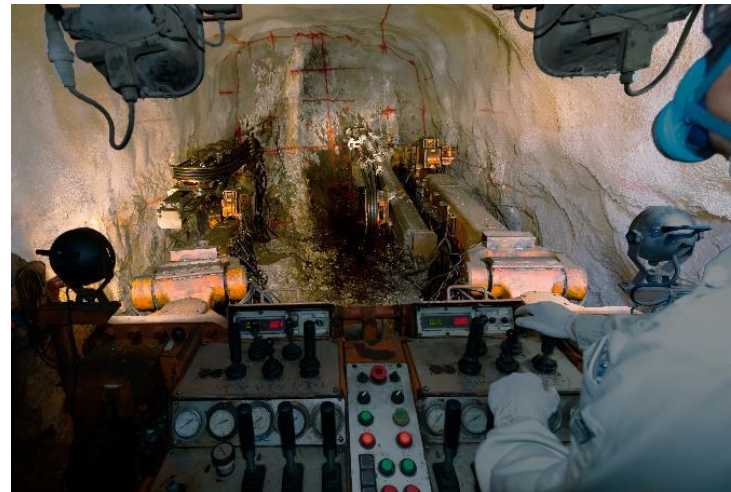
坑内での採掘の様子
