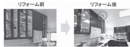
キッチンにも吹出し口を設置。寒い時期の家事もらくらく。
